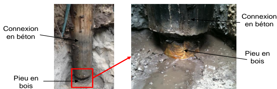
Figure 2. Pieu en bois et connexion en béton
