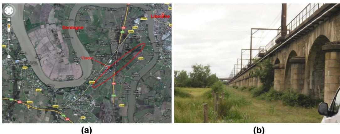
Figure 6. Localisation du site (a) et vue de l'ouvrage (en direction de Bordeaux) (b)
