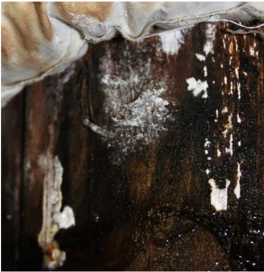
Figure 73 : Détail d'un pieu montrant le développement en surface de mycélium.
