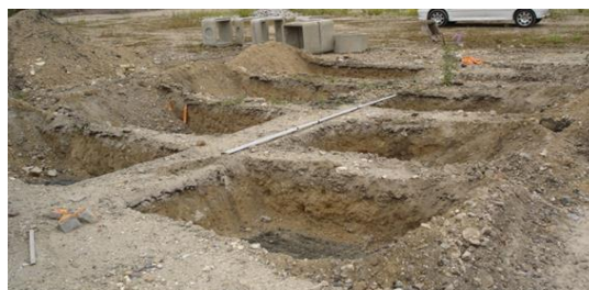
Figure 25. Décaissement de la couche de remblai
