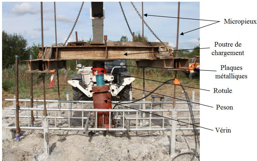
Figure 66. Essais de chargement du pieu n°2 – Cubzac-les-Ponts
