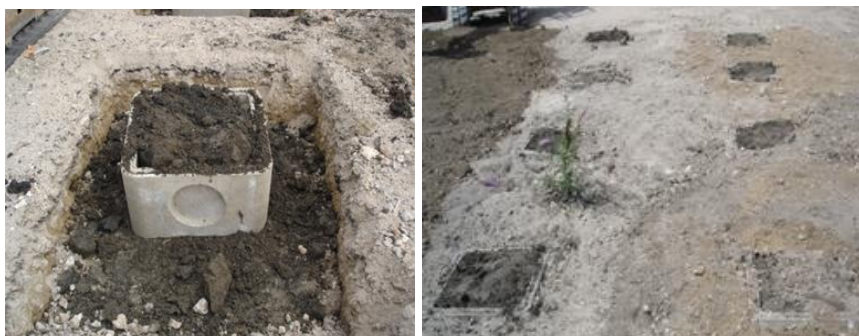
Figure 27. Remblaiement des regards en béton
