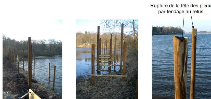
Figure 8. Construction d'un belvédère piéton dans la commune de Sanchev (Vosges)
