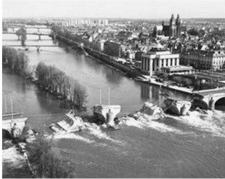
Figure 2 : Pont Wilson à Tours, 1978. Effondrement du tablier dû à un affouillement des piles.
